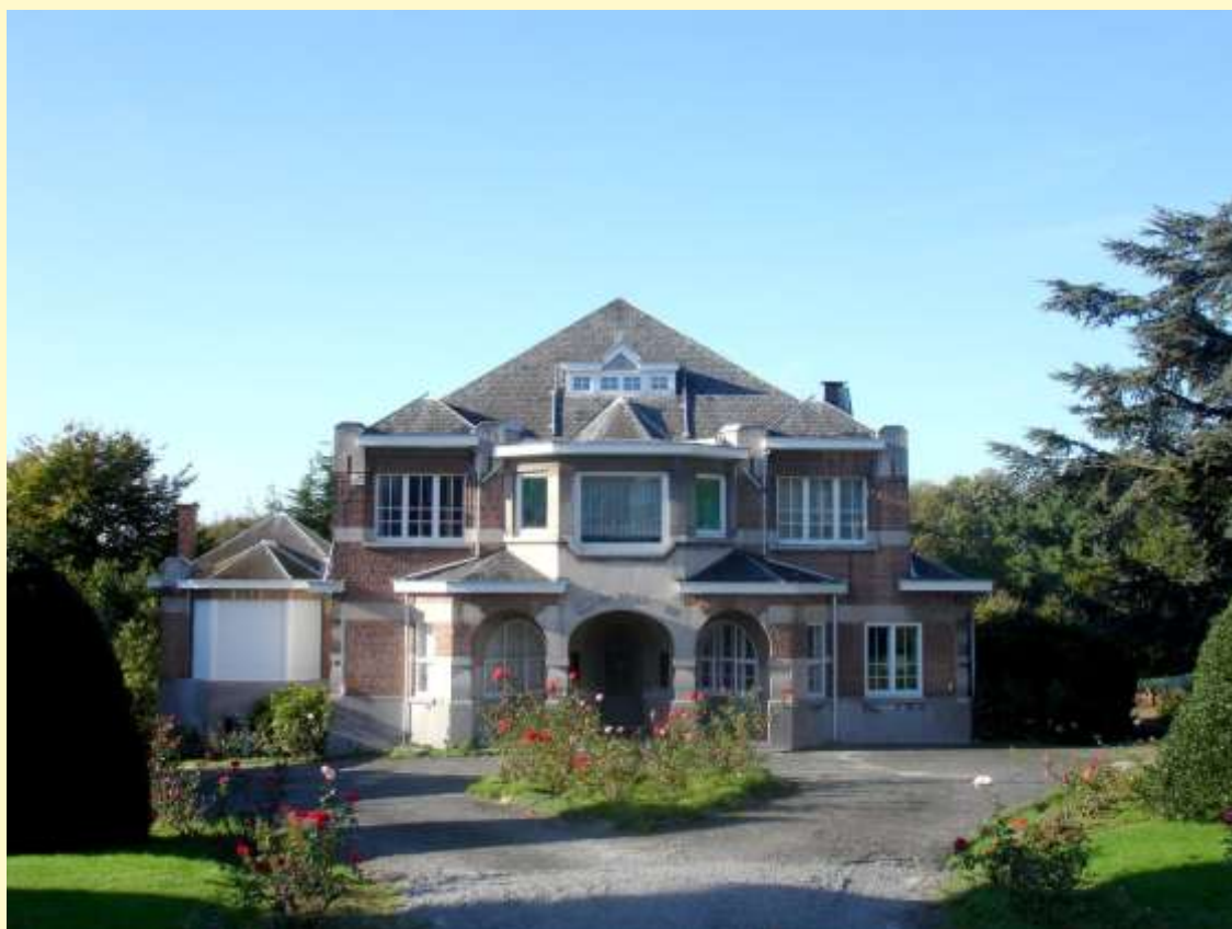
Photo 2008 - L'annexe ajoutée à gauche a encore été construite par EDB en 1928. Les cheminées initiales ont disparu en... ?
