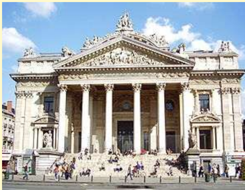
Bâtiment de la Bourse de Bruxelles, construit par Léon Suys, (1869 – 1874)
