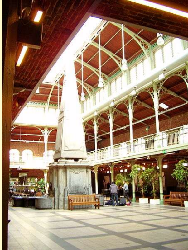
Intérieur des Nouvelles Halles St. Géry. Œuvre de l'architecte Vanderheggen 1882. - Structure fer/verre à l'intérieur mais extérieur encore « néo-renaissance flamande ».
