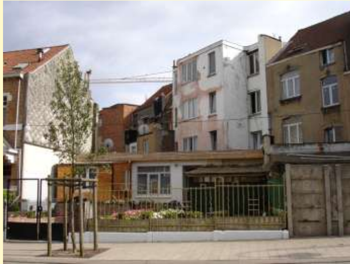
Photo 2008 : vue arrière. Bâtiment transformé et en mauvais état.
