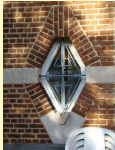
Façade latérale arrière Détail de maçonnerie
