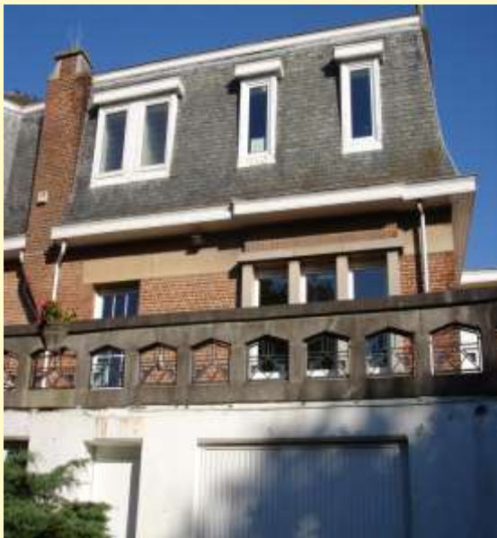
Belle toiture à la Mansart Avec ses brisis en petites ardoises bleues Balustrade en pierre de dessin géométrique
